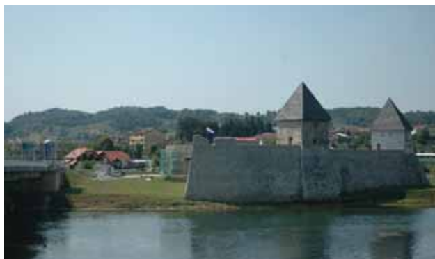
Vista del puente de Hrvatska Kostajnica.
