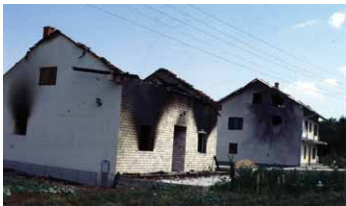
Casas de Kijevo afectadas por los bombardeos.
