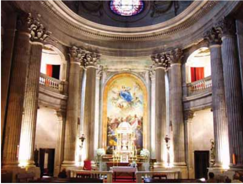
Altar mayor de la capilla del Sagrario en la catedral de Jaén. Columnas corintias pareadas sostienen el tambor sobre el que apoya la bóveda elíptica.
