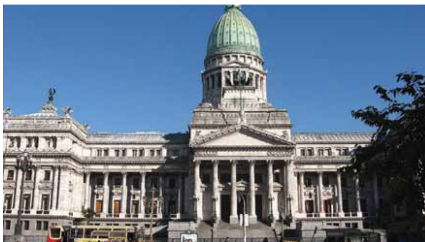
Palacio del Congreso de la Nación Argentina, Buenos Aires. Preside el edificio, a 80 metros de altura, su gran cúpula sobre tambor circular.
