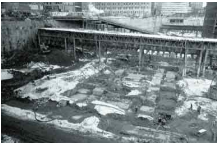
Cimientos de las Twin Towers en la época de comienzo de las obras.
