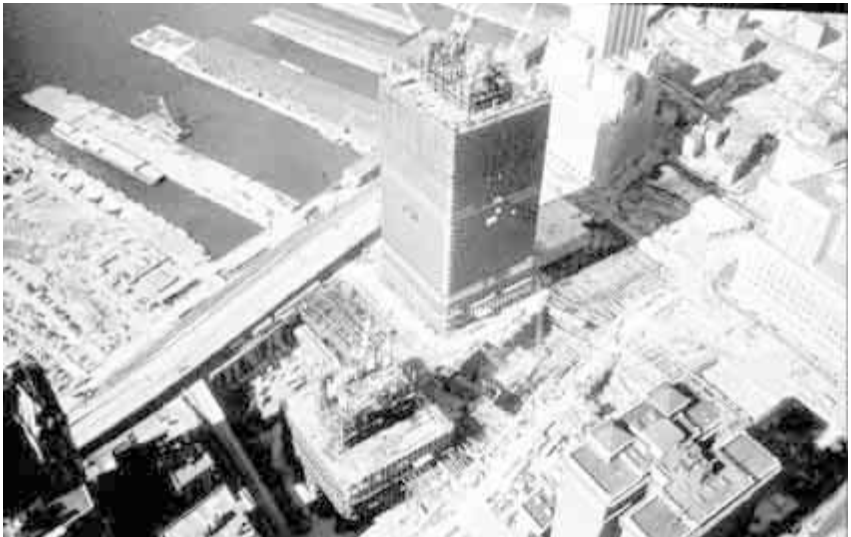
Inicio de la construcción de las colosales Torres Gemelas
