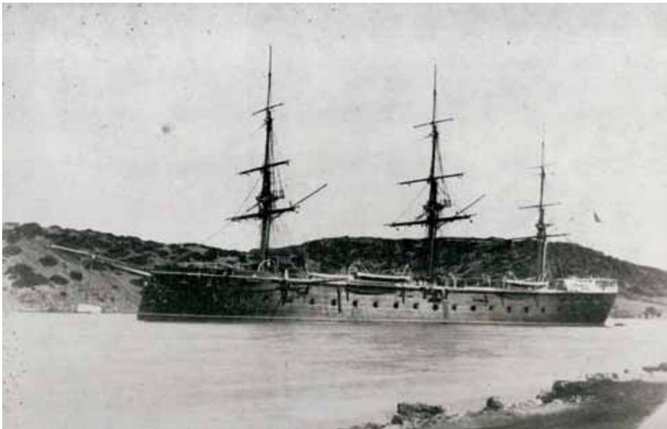
La fragata acorazada española *Vitoria* construida en Inglaterra. La coraza en los costados, la máquina de vapor y la artillería de retrocarga con proyectiles explosivos convirtió a la fragata decimonónica en una unidad formidable capaz de pulverizar un navío clásico de combate.
