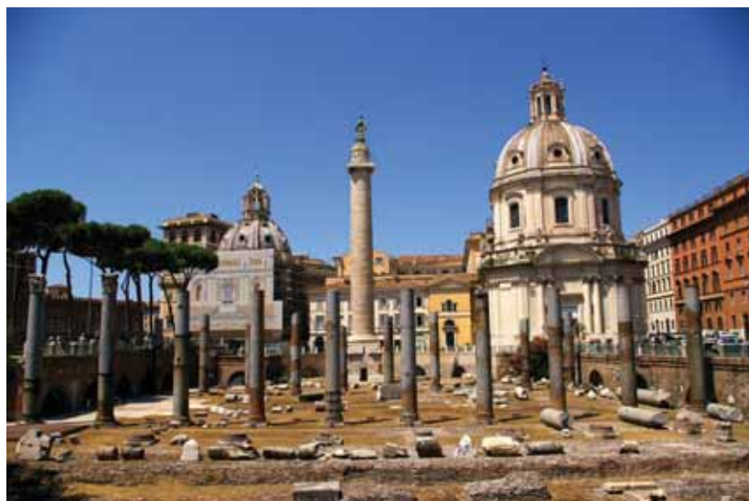
Vista de las construcciones de Trajano en los foros imperiales
